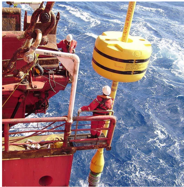
Figura 12: Flutuador instalado em um riser . (Balmoral Offshore Engineering, 2018)
